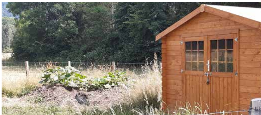
Construction d'un abri
