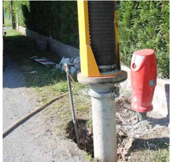
Déplacement de la borne à incendie
