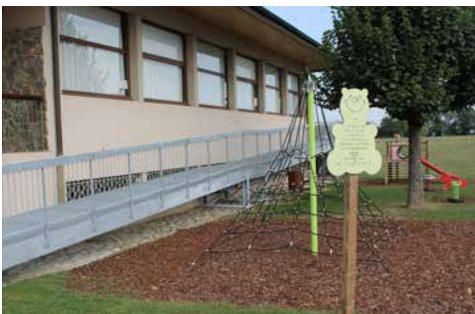
Rampe d'accès handicapés salle des fêtes
