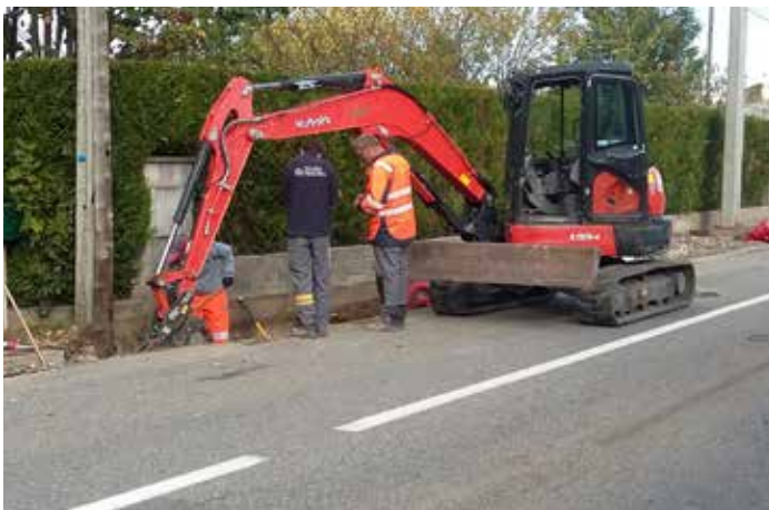
Creusement de la tranchée d'entoussement des réseaux
