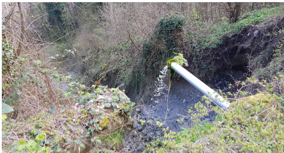
Figure 32 : Ruisseau des Mouilles, alimenté par une source (droite) et le réseau de recueil des eaux pluviales (gauche) (vue vers le nord-est)
